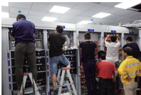
图 3-10 南京铁道职业技术学院师生进行信号组合配线施工
